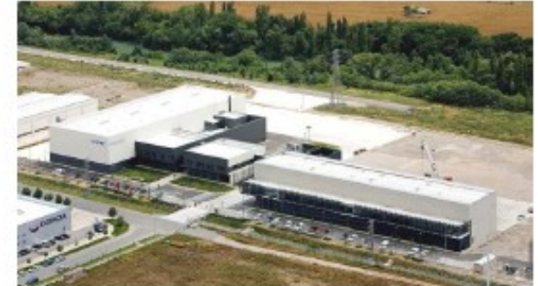
Laboratorio de Ensayo de Aerogeneradores Sangüesa (Navarra)
