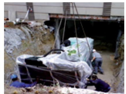
Entrada no edificio do novo grupo electróxico
