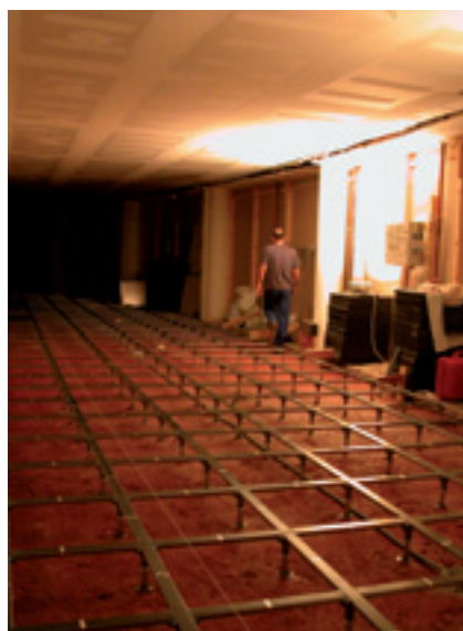
Nova superficie técnica acondicionada
